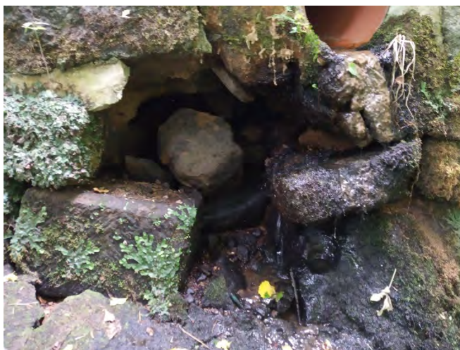
Kaverna pod odpadním potrubím
