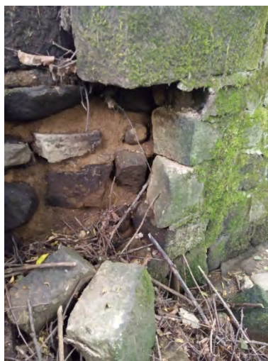
Detail rozpadlého zdiva u bezpečnostního přelivu
