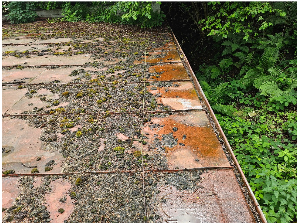
NESPRÁVNÉ NAPOJENÍ KRYTINY NA ATIKU
