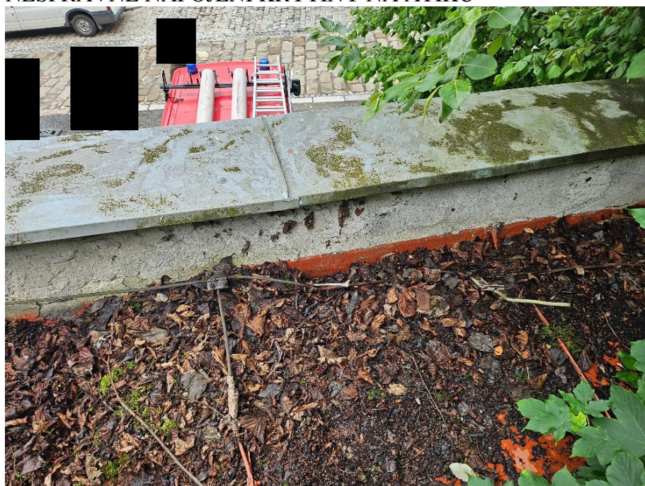
NESPRÁVNÉ NAPOJENÍ KRYTINY NA ATIKU
