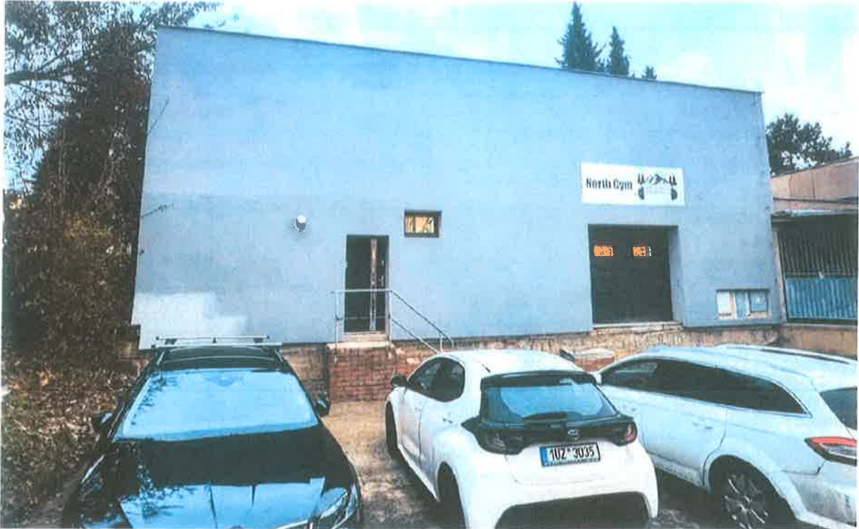
Obrázek 3 – Stávající stav, fotodokumentace žadatele. Dle KN se jedná stále o stavbu technického vybavení.
