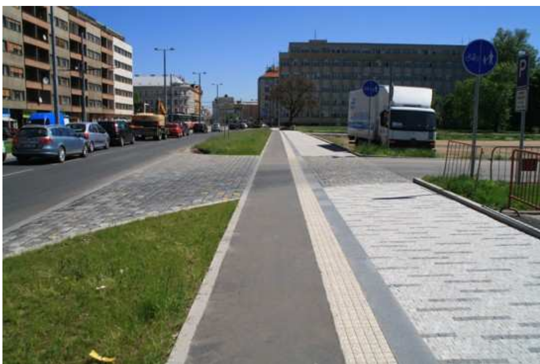
ilustrační foto (Praha 7, Letná) – jednosměrný pás pro cyklisty v místě výjezdu mimo PK, přednost cyklistů daná zákonem zde musí být jasně zvýrazněna kontinuálním provedením pásu ve shodné výšce i provedení (inspirace pro řešení stezek podél sběrných kom. v katastru Prahy 21)
