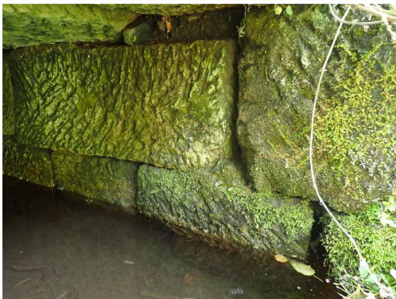
Detail levobřežní opěry na výtoku
