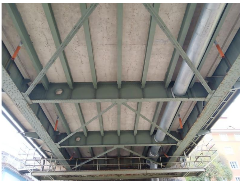
Podhled pravobřežního pole u opěry.
