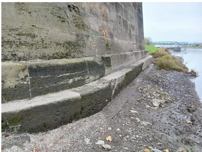
Pata pravobřežního pilíře.
