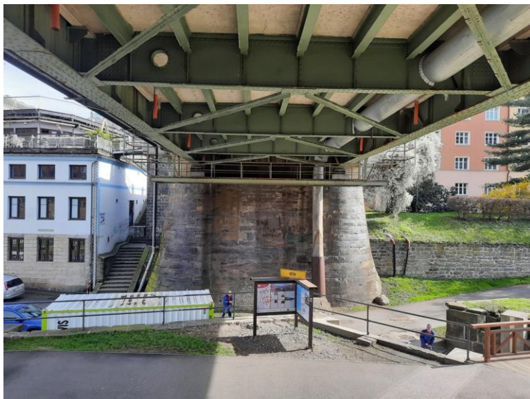
Pravobřežní opěra, pohledový líc. Revizní lávka u opěry.
