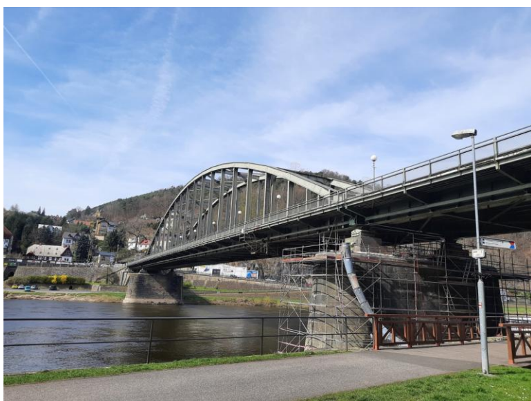
Pravobřežní pilíř s lešením při opravě krycí žb desky na vrchu pilíře z vtokové strany.
