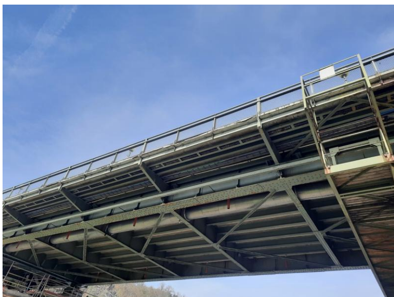
Podhled pravobřežního pole u opěry.
