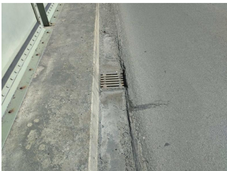
Odvodňovač povrchu mostu s odvodňovacím proužkem ve středním poli.
