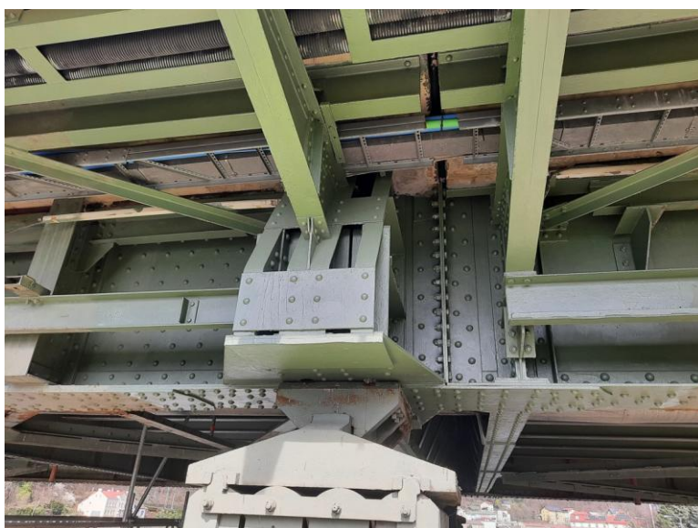
Opravená PKO a mostní závěr nad pravobřežním pilířem.
