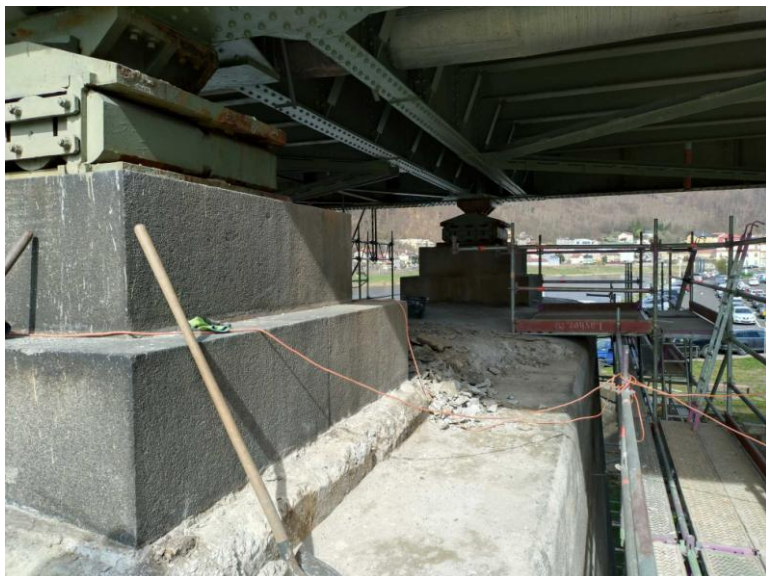
Ubouraná betonová krycí deska pravobřežního pilíře s ložisky.
