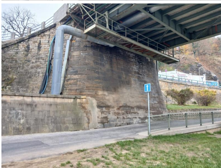
Podhled levobřežního pole u opěry s revizní lávkou.
