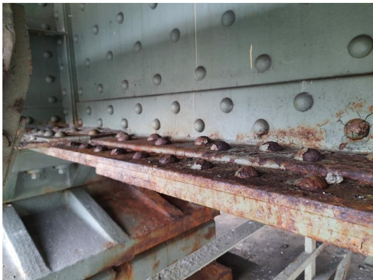
Dolní pásnice hlavního nosníku nad výtokovým ložiskem pravobřežního pilíře.
