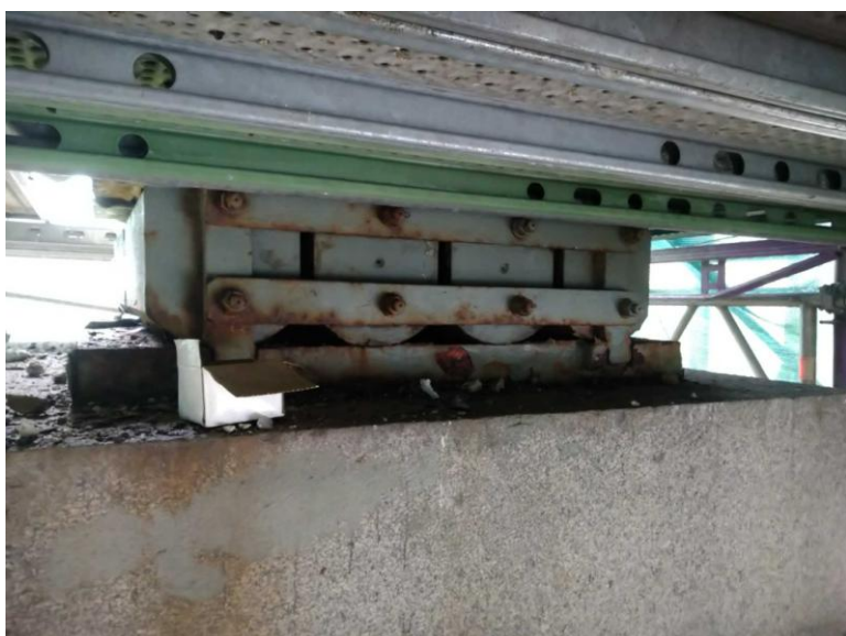
Spodní část (pod podlahou lešení) vtokového ložiska na pravobřežním pilíři.
