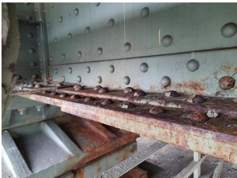
Dolní pásnice hlavního nosníku nad výtakovým ložiskem pravobřežního pilíře.
