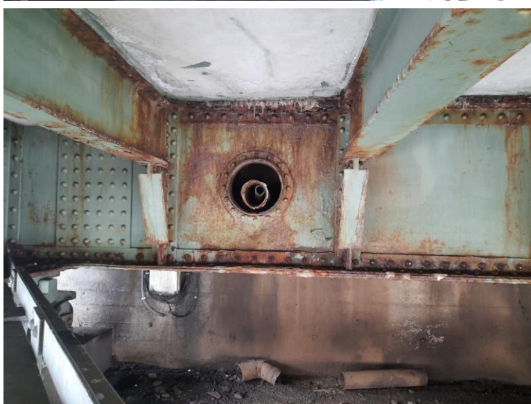
Koncový příčník nad pravobřežní opěrou.
