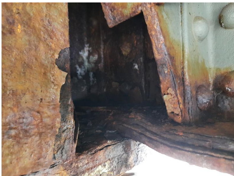
Detail styku příčnicku s hlavním nosníkem nad vtokovým ložiskem pravobřežního pilíře.
