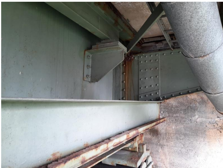
Způsob uložení chodníkové desky na vtokové straně u pravobřežní opěry.
