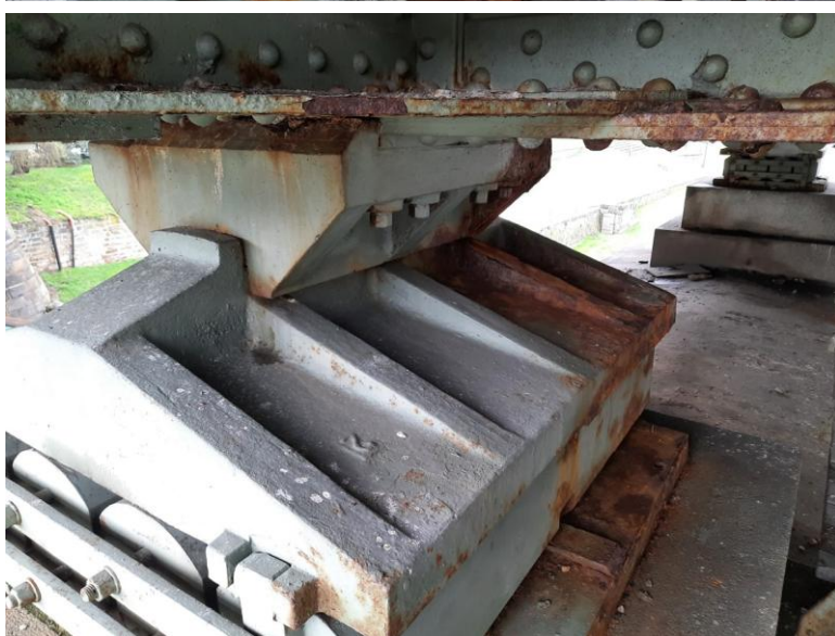
Výtokové ložisko pravobřežního pilíře.
