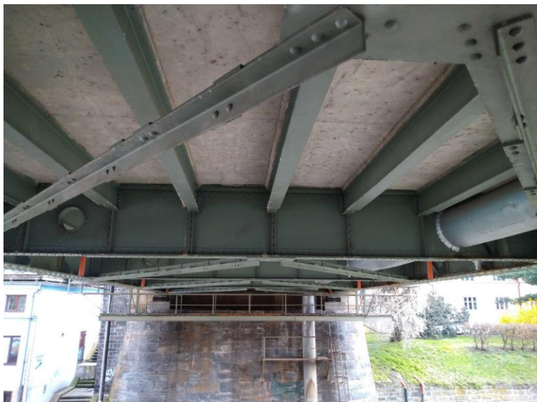
Podhled pravobřežního pole.
