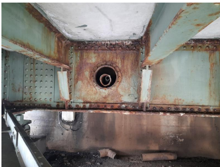
Koncový příčník nad pravobřežní opěrou.
