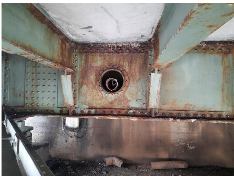
Koncový příčník nad pravobřežní opěrou.
