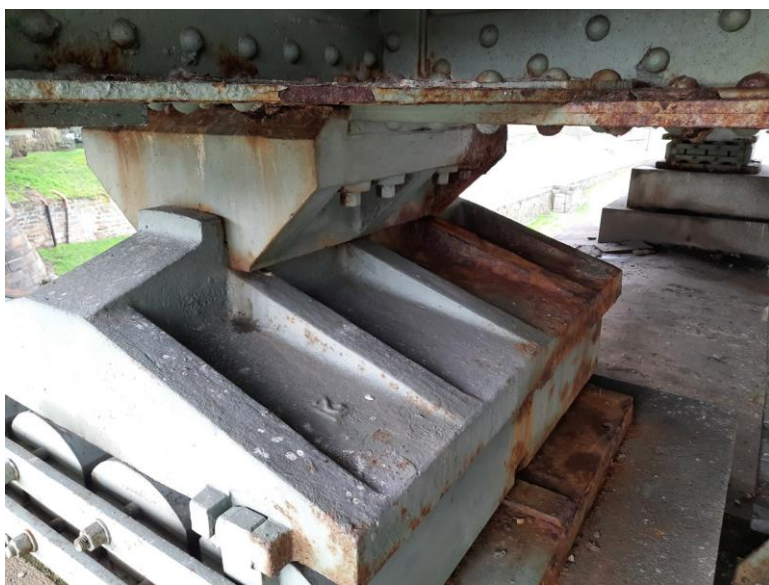
Výtokové ložisko pravobřežního pilíře.
