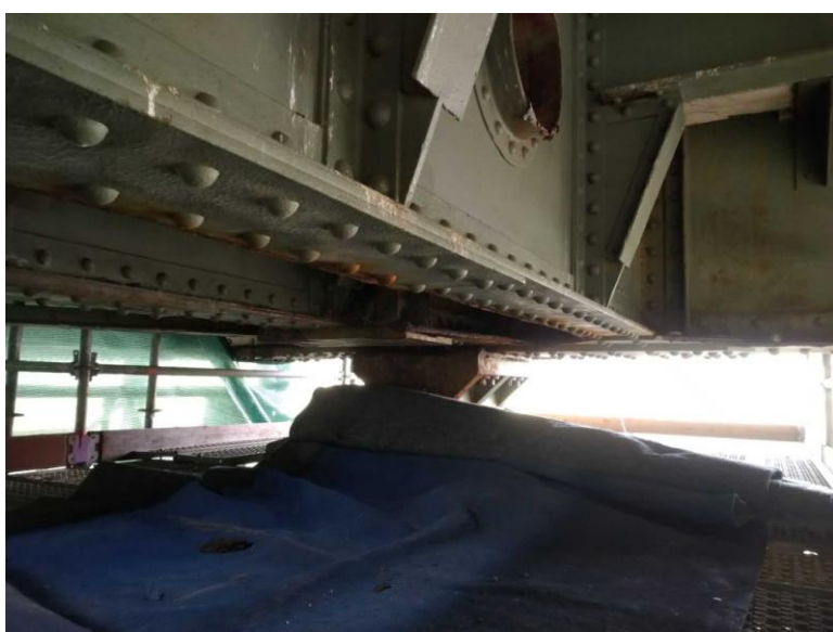
Vrchní část (nad podlahou lešení) výtokového ložiska na pravobřežním pilíři.
