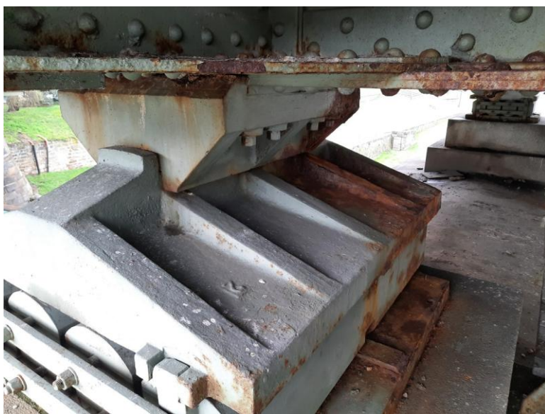
Výtokové ložisko pravobřežního pilíře.
