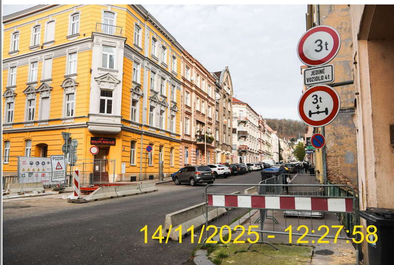
Celkový pohled na most z pravobřežního předpolí – výtoková strana. Dopravní značení ze 14.11.2025 již po osazení DZ (foto správce)
