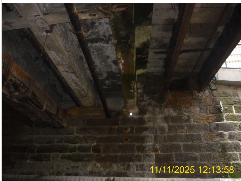
Podhled NK návodní kraj mostu směrem k Op2
