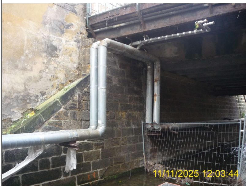
Pohled na křídlo/nábřežní pravobřežní zeď Op2 výtoková strana
