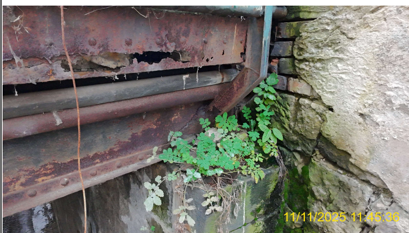
Stav ocel. nosníků v uložení na opěry (z dronu)
