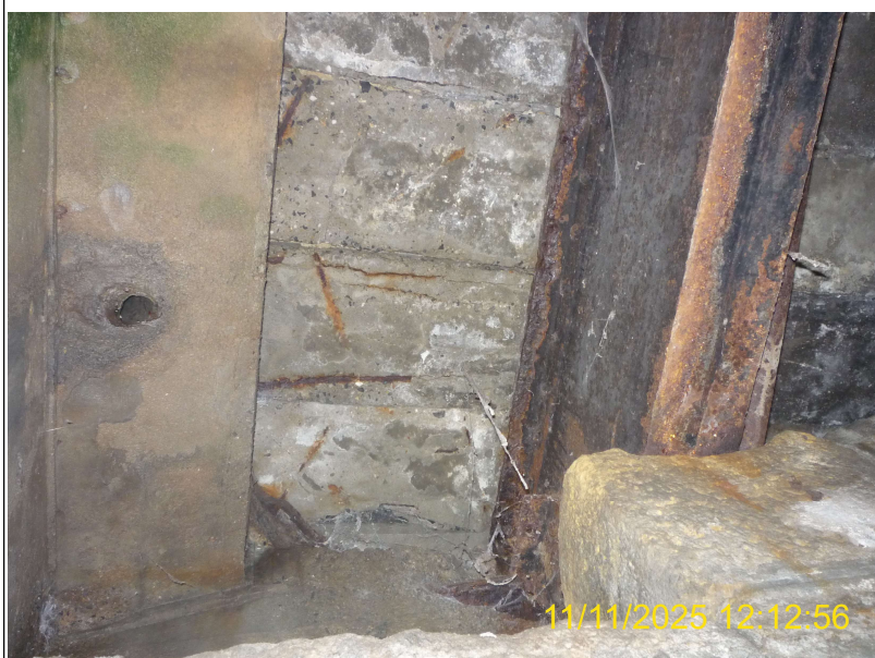
Podhled NK mezi betonovou částí a chodníkovou částí podepíranou ocel. nosníky
