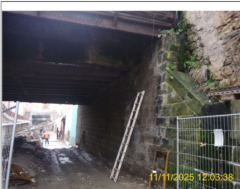
Pohled na křídlo/levobřežní zeď Op1 výtoková strana
