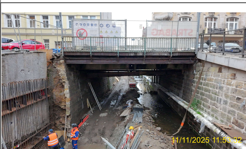
Pohled na vtokovou stranu (z dronu)
