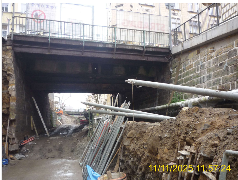
Pohled na křídlo/nábřežní pravobřežní zeď Op2 nátoková strana
