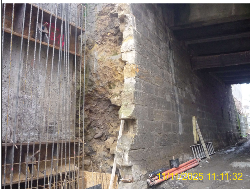
Pohled na křídlo/nábřežní zed' Op1 nátoková strana
