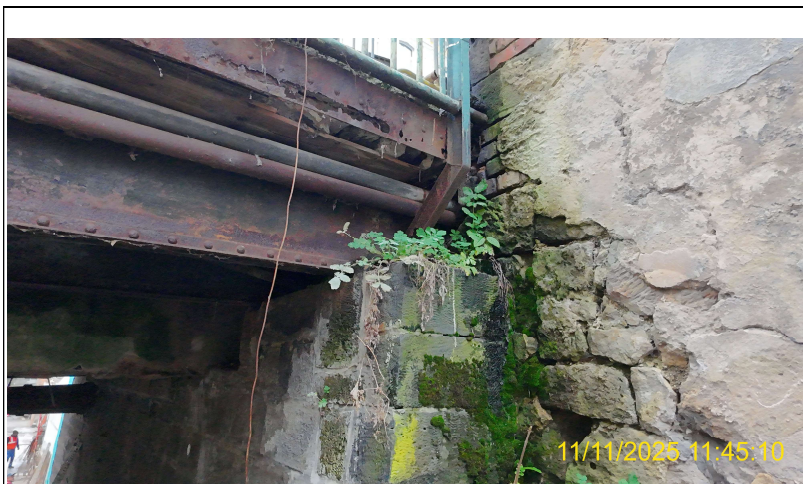
Úložný práh na Op1 (z dronu)
