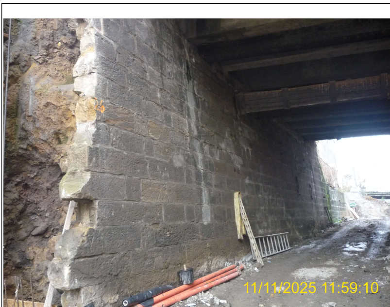
Pohled na Op1 levobřežní
