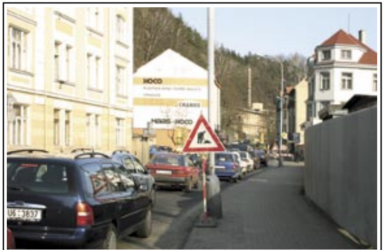
Na Teplické ulici začala oprava kanalizace. Stejně jako u většiny ostatních oprav na této dopravní tepně není investorem město Děčín. Podrobnosti k této opravě přineseme v dalším vydání zpravodaje.
