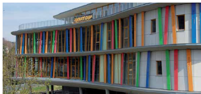
Na revitalizaci objektu Atlantik získá Děčín z ROP Severozápad přibližně 170 milionů korun
