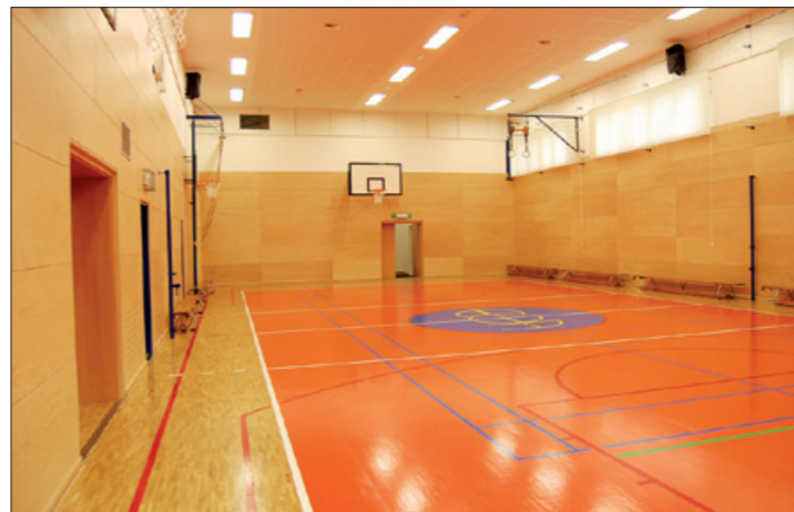
Díky dotaci z ROP Severozápad má děčínská Evropská obchodní akademie novou tělocvičnu.
